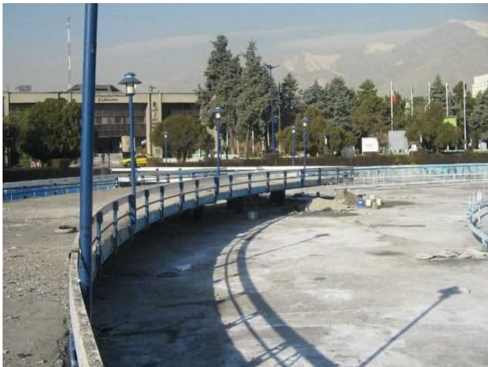
آبنمای مرکزی در حال بازسازی
